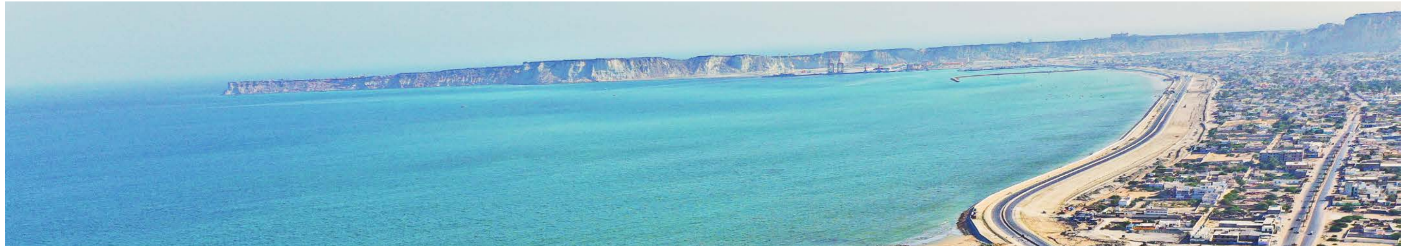
巴基斯坦瓜达尔港东湾快速路 East Bay Expressway, Gwadar Port, Pakistan
