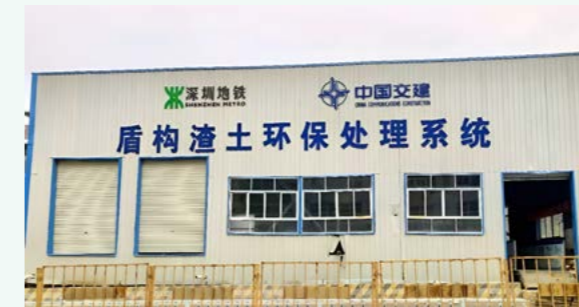
盾构渣土分离系统 Shield muck separation system
