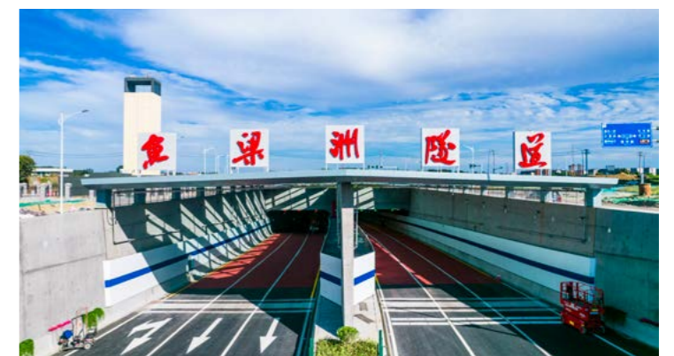
由公规院主持设计、二航局参与投资建设的鱼梁洲隧道实现沉管隧道建设全产业链国产化
