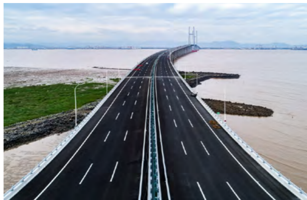
浙江省台州湾大桥及接线工程
