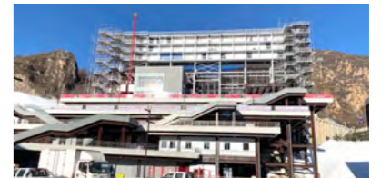
北京冬奥会竞速结束区临建设施——评论员席3层集装箱综合体，下部为竞速结束区永久设施
