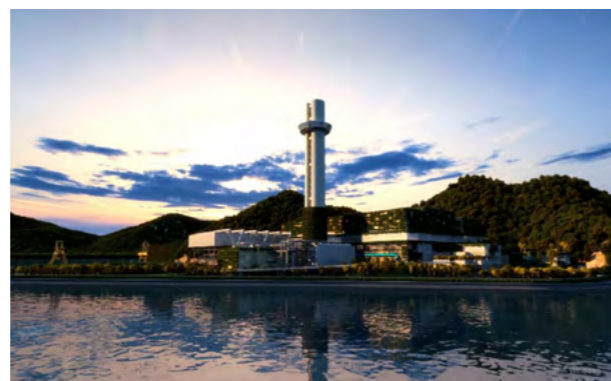
香港综合废物处理项目
