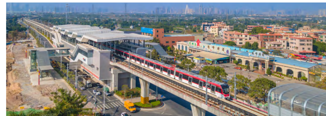
佛山地铁 2 号线一期工程
