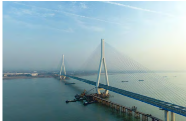
武汉市四环线沌口长江公路大桥
