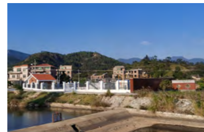
农村分散式污水处理站
