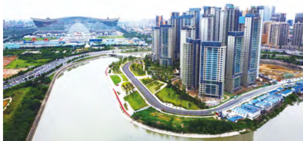
四川锦江流域水环境治理项目
