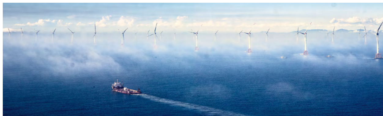
三峡阳西沙扒海上风电项目
