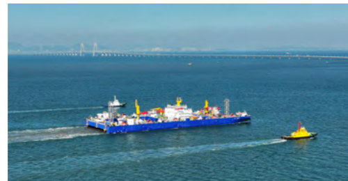
截至2022年1月25日，深中通道已完成22个沉管管节对接，管节安装长度达3,382.8米
