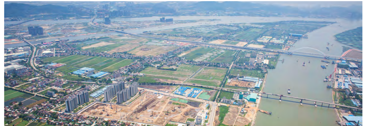
南沙灵山岛尖横沥项目实景图
