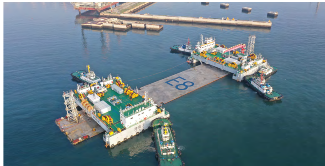
8月25日，大连湾海底隧道 E8 管节成功安装，40 天内安装 3 个管节，跑出国内沉管安装“新速度”
