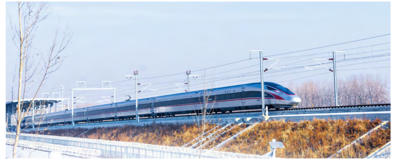
京雄城际铁路
